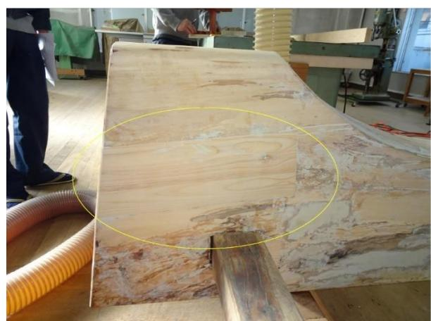
黄色のマーク部分が補修部材、白い部分は木部用パテを充填補修した箇所です（4枚とも）。
